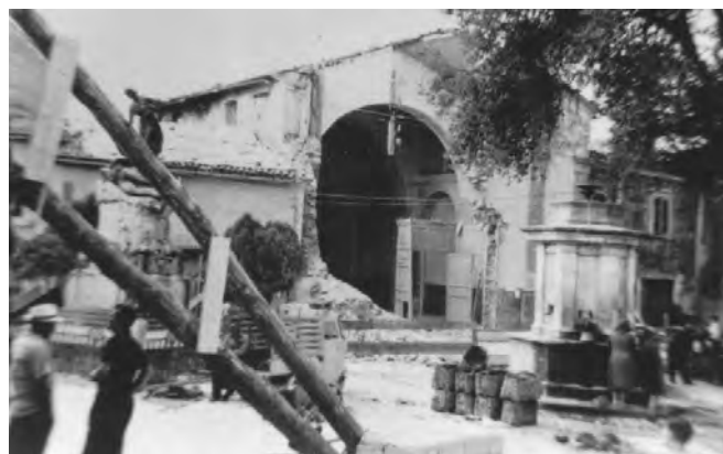
I danni del terremoto alla Chiesa della Concezione
