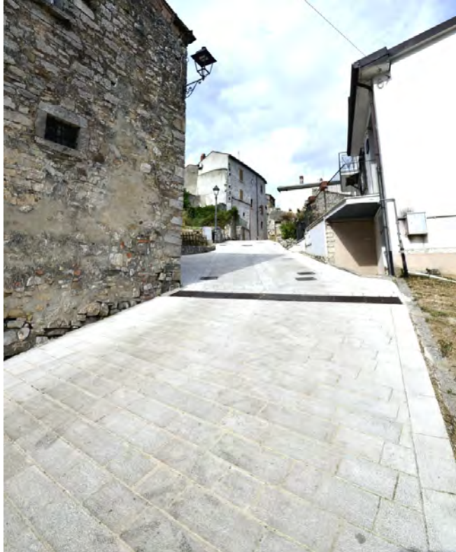
Via L. Galganetti - La nuova pavimentazione
