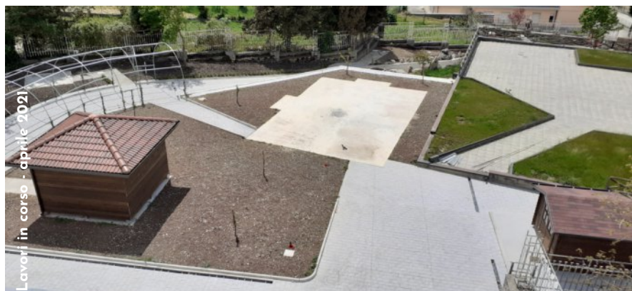
Inizio lavori - luglio 2020
