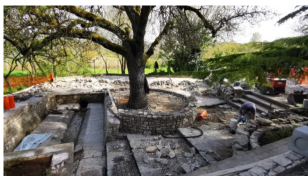
«Fontanella» - Lavori in corso
